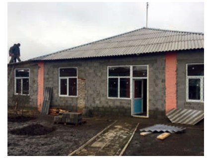
Fleißige Helfer auf dem Bau
